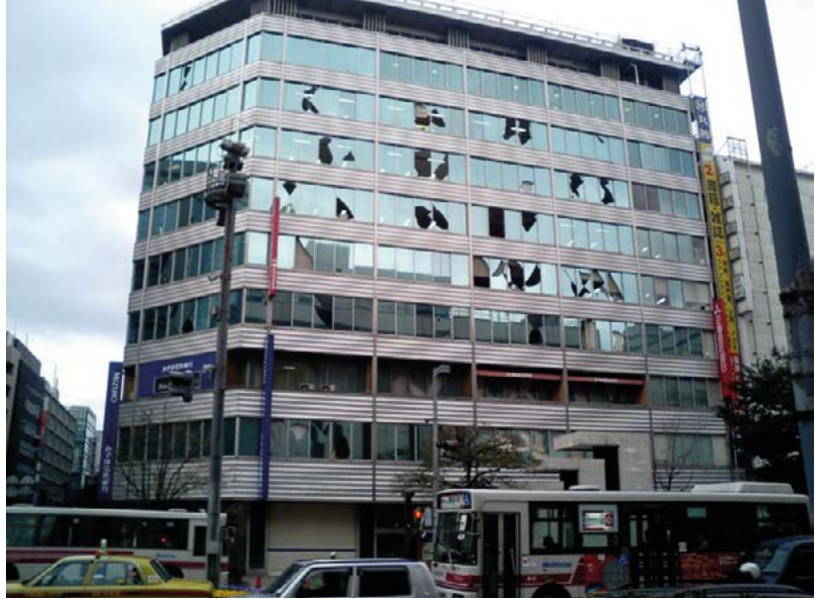
Resim 8. Yapısal cam giydirmce cephe sistemi üzerinde deprem etkisi [15]
