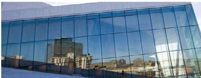
Resim 4. Strüktürel silikonlu giydirmce cephe sistemi [URL 4]
