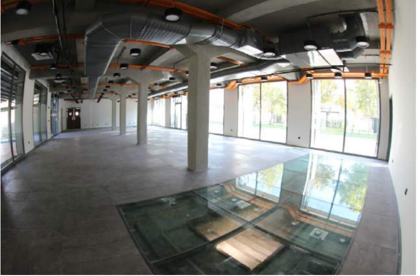
Resim 10. İtfaiye Binası İç Mekan, 2016.
